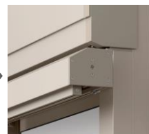
収納ボックスを 固定し完成
