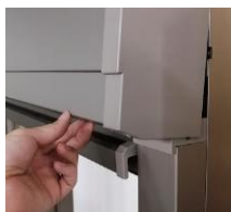
シャッターボックス カバーを浮かせる
