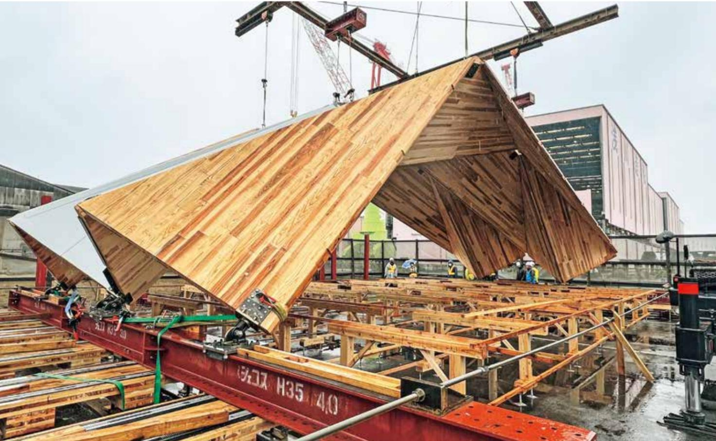
CLT折板架構の施工実験。東京大学生産技術研究所の藤原幹雄教授指導のもと、施工性も含め合理的な木造大スパン架構を開発。この工法は大阪万博の施設にも応用される【写真：KAP】
