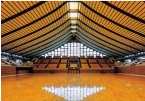
日本大学で長らく教鞭をとった小林美夫の設計による、弓道場、相撲場、大道場など大小10棟に及ぶ建築からなる総合武道館。軒の出が深い勾配屋根は、厳しい風雪から外壁を守り、山並みのような風景を創出している。構造設計は、岩手県営体育館 (MAP 02) も担当した齋藤公男が担当。ここでは、張弦梁構造を採用しており、この構造形式がもたらす懸垂線が、むくれた屋根と天井の形に現れている。「武道のもつ高い精神性に相応しい伝統的風格の追求」(『新建築』新建築社、1990.8) がされ、庇先端に施した雪落としのデザインや、矢羽を連想させる客席の手すりなど細部のディテールも美しい
