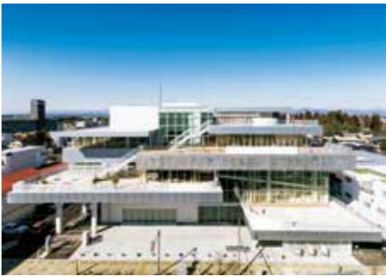
須賀川市民交流センター tette (2019) 福島県須賀川市の東日本大震災復興事業による複合施設。組織事務所と若手建築家が組むことを条件としたプロポーザルにおいて、石本建築事務所+畝森泰行建築設計事務所が選ばれた。図書館やミュージアムなどの機能をスラブをずらしながら積層させることで、多様なテラスや軒下空間を生み出している [設計：石本建築事務所+畝森泰行建築設計事務所、撮影：川澄・小林研二写真事務所]
