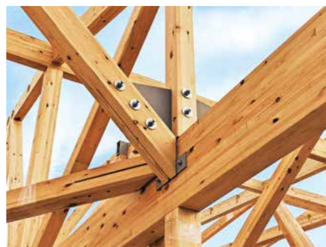
欧州アカマツの集成材を使用した梁と方杖・火打ちの接合部 [写真：楠本玄英構造設計事務所]
