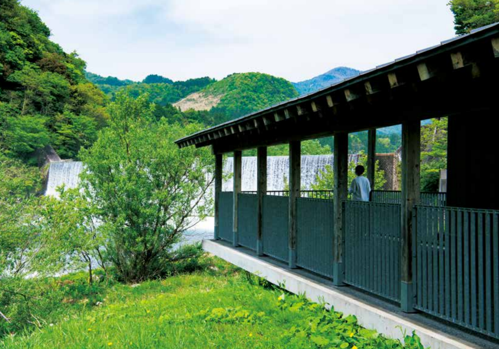
四阿越しに本宮砂防堰堤を見る
