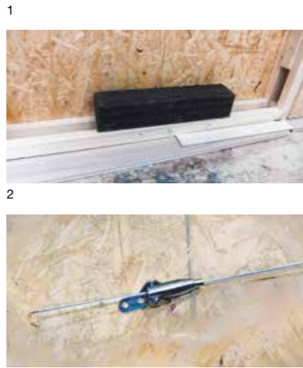
1 展示風景。6分割された空間でそれぞれのブランドが展示を行った 2 先端から1m部分の壁の中に設置されたウェイト 3 壁頂部をつなぐクロワイヤーの接合部 [写真1-3：楠本玄英構造設計事務所]
