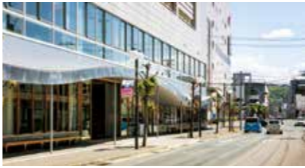
北上市保健・子育て支援複合施設 hoKko (2021) 岩手県北上市の中心地にある商業施設の1、2階を保健福祉や子育て支援機能などを備えた複合施設にコンバージョンした。1階の中央には検診用の車両が入るほどの大きな屋内広場を設け、そのフロア全体を波形の光天井が覆う。光天井の起伏の下に多様な居場所が生まれ、2階では波打つ遊具となり、外部には庇となって周囲のアーケードと連続する [設計：UTA／Unemori+teco Associates、撮影：中村 絵]
