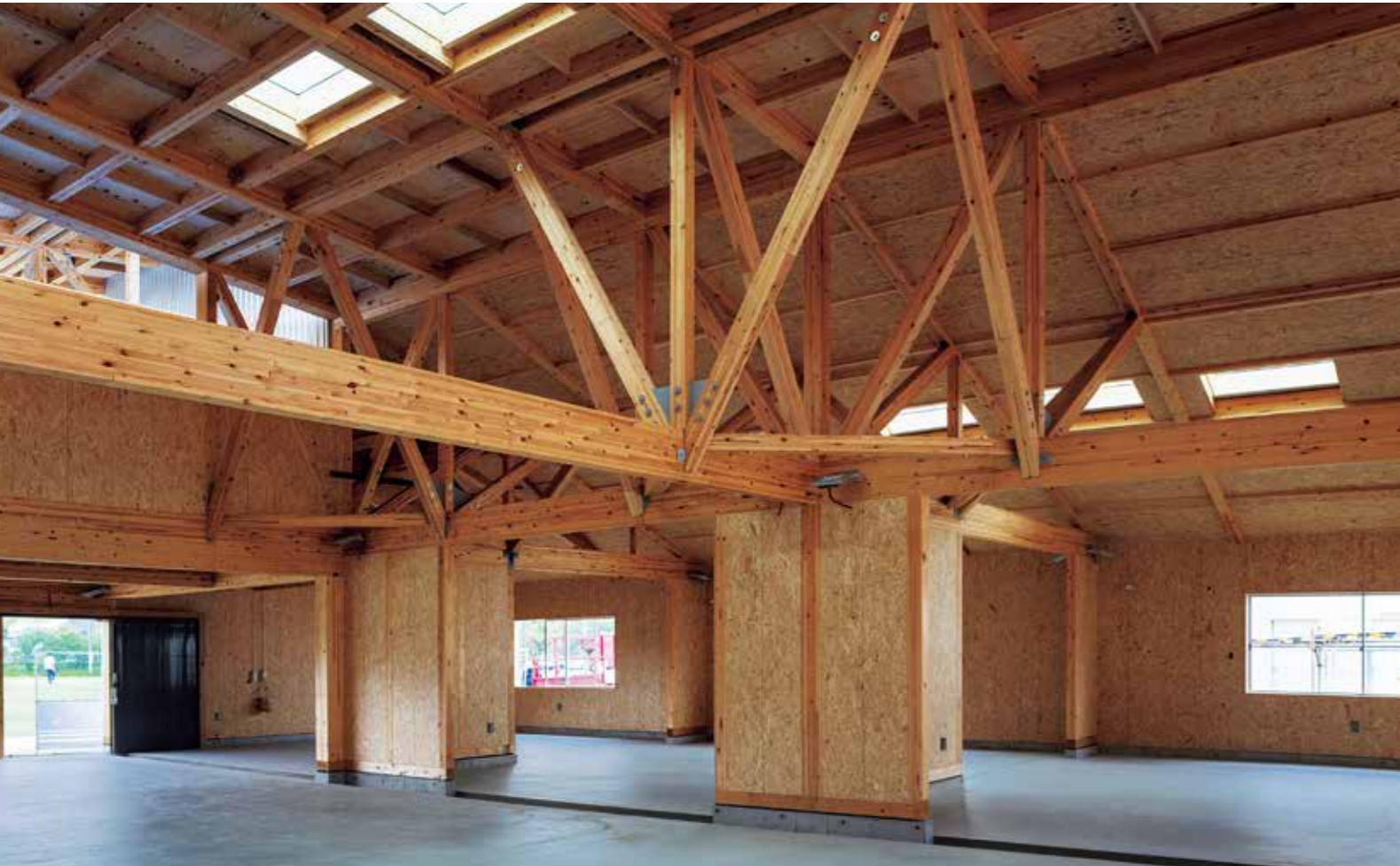
方杖とトップライトが印象的な内観。梁が大きく抜けた架構とすることで天井高を稼ぎ、ボールなどを使用する機能面に配慮するとともに、視覚的な開放感を実現している [写真：齋藤さだむ写真事務所]
