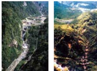
常願寺川水源部の巨大なくぼ地「立山カルデラ」内には、安政の大地震による崩壊土砂が約2億㎡残るといわれ、その流出土砂が原因で、常願寺川は洪水・氾濫を繰り返す「日本一の暴れ川」と呼ばれていた。これを治めるため、県、そして国の直轄事業として引き継がれ完成した砂防施設。不安定な土砂をカルデラの出口で抑え込む「白岩堰堤」(写真左、設計指導：赤木正雄)、カルデラ内の土砂の動きを抑える「泥谷堰堤」(写真右、設計指導：赤木正雄)、そして常願寺川中流部の「本宮堰堤」(写真下)は、土砂を一度貯め、下流へ穏やかに流す役目をもつ。修景計画も見事な本宮砂防堰堤は、間近に見学可能だ。3堰堤は常願寺川砂防施設として国の重要文化財 [写真左上2点提供：国土交通省 北陸地方整備局 立山砂防事務所]
