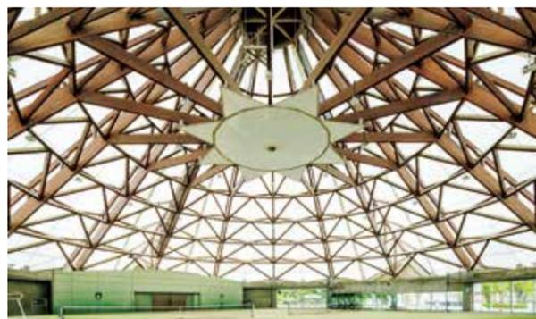
富山湾に近いスポーツ公園内に立つ、テニスコートを2面収容した膜構造のドーム施設。膜屋根には、テフロン樹脂コーティングガラス繊維織布が使われており、晴天率が低く、冬場の海風が強い富山の地にあっても、膜の光拡散効果によって明るく安定した室内環境を提供している。印象的な16角錐の跳ね上がった膜屋根の形は、積もった雪を左右に落とすため、ドーム天井の大断面集材材を用いた16本の登り梁も美しい。第25回富山県建築賞受賞
