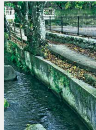
第6ゾーン「水と暮らし」：川沿いに桜の並木道が延びる。川と道路の間に30cm程度の隙間を設け、ホテルの幼虫が川から上りたがる環境を整えた
