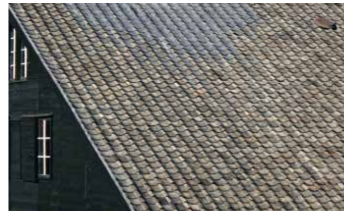
[写真5] 保全工事直前の屋根瓦
