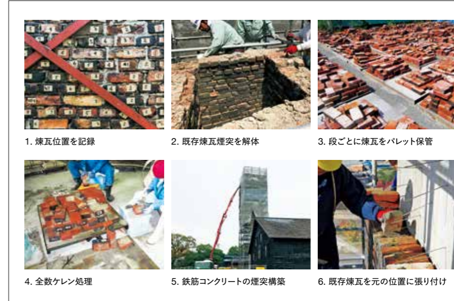
[写真2] 煙突保全工事の工程
