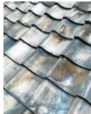
[写真10] 新しく葺かれた淡路瓦
