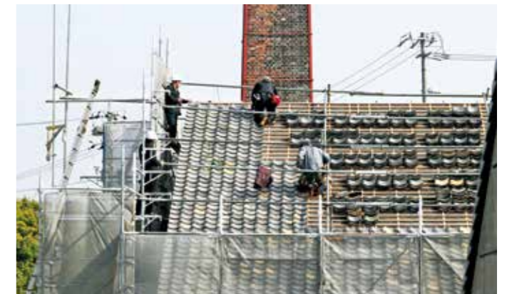
[写真6] 瓦葺きの様子
