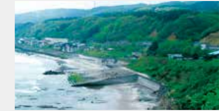
2 海岸整備の一環としてつくられた緩傾斜護岸。砂浜を分断していると地域住民からは不満の声が上がっていた [提供：NPO法人サステイナブルコミュニティ総合研究所]
