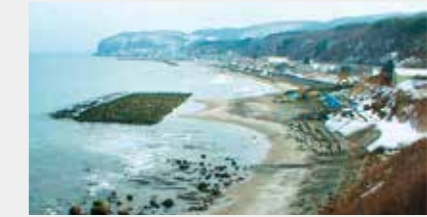
4 当初の低天端幅広消波堤。完成形が施工者と十分に共有できず、住民の思い描く風景とは異なるものがつくられた [提供：NPO法人サステイナブルコミュニティ総合研究所]
