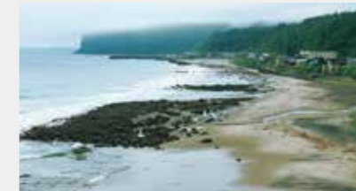
5 現在の低天端幅広消波堤。写真は大潮の日における干潮時の様子。先の反省から住民を交えた現場確認を経て、理想形へ改築を行った
