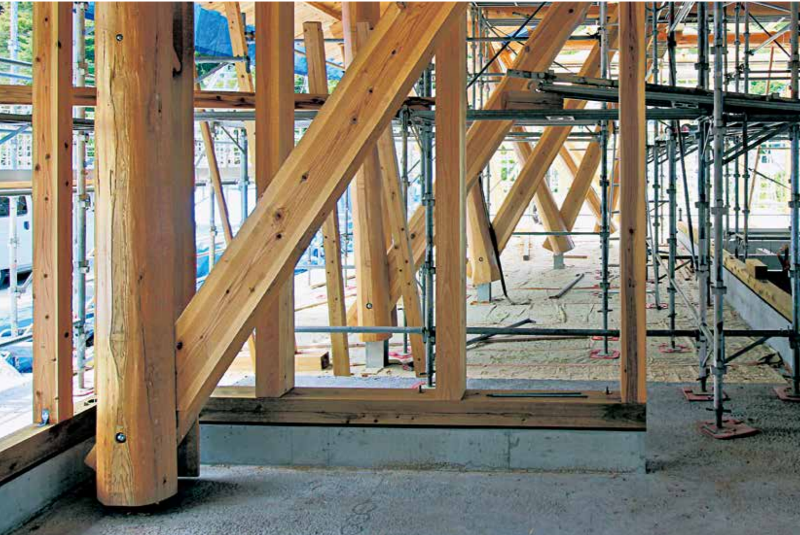
建設中の上勝町ゼロ・ウェスト・センター内観。写真手前から奥にかけて、斜柱の柱脚の位置が徐々に内側に移動しているのがわかる [写真：山田憲明構造設計事務所]
