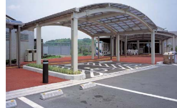
身障者用駐車スペースを隈なくカバーする8m幅の屋根 (国道2号今津PA休憩施設)
