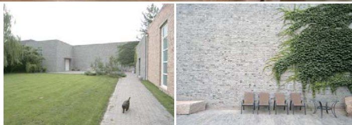
艾未未設計による自邸。アトリエ、ギャラリー「芸術文件倉庫」を備えている
