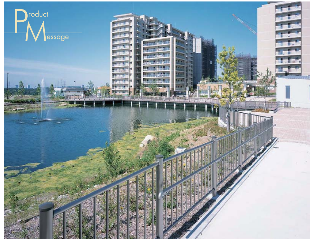
池を臨む張り出し部分は、アルミ柵の本体を加工して美しい曲線を実現しました（あさぎ里山公園）
