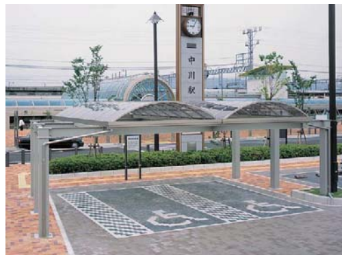
両支持柱は幅 7m、片支持柱は幅 5.5m。鉄骨を用いて、安心して快適な駐車スペースを実現しています(伊勢中川駅東口広場・西口広場)
