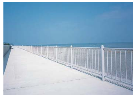
真っ白な柵が、さわやかな海岸風景をより引き立てます（新居傾斜堤防）
