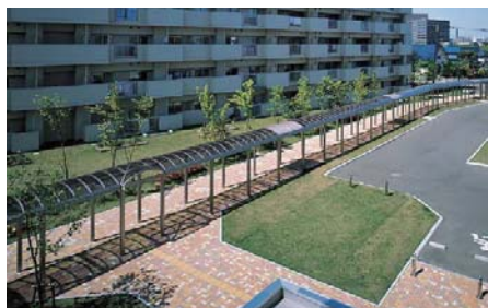
日よけ、雨よけに快適な積雪タイプの通路シェルター。傾斜・コーナーの3次元加工がきれいな曲線を描きます (下野幌団地)
