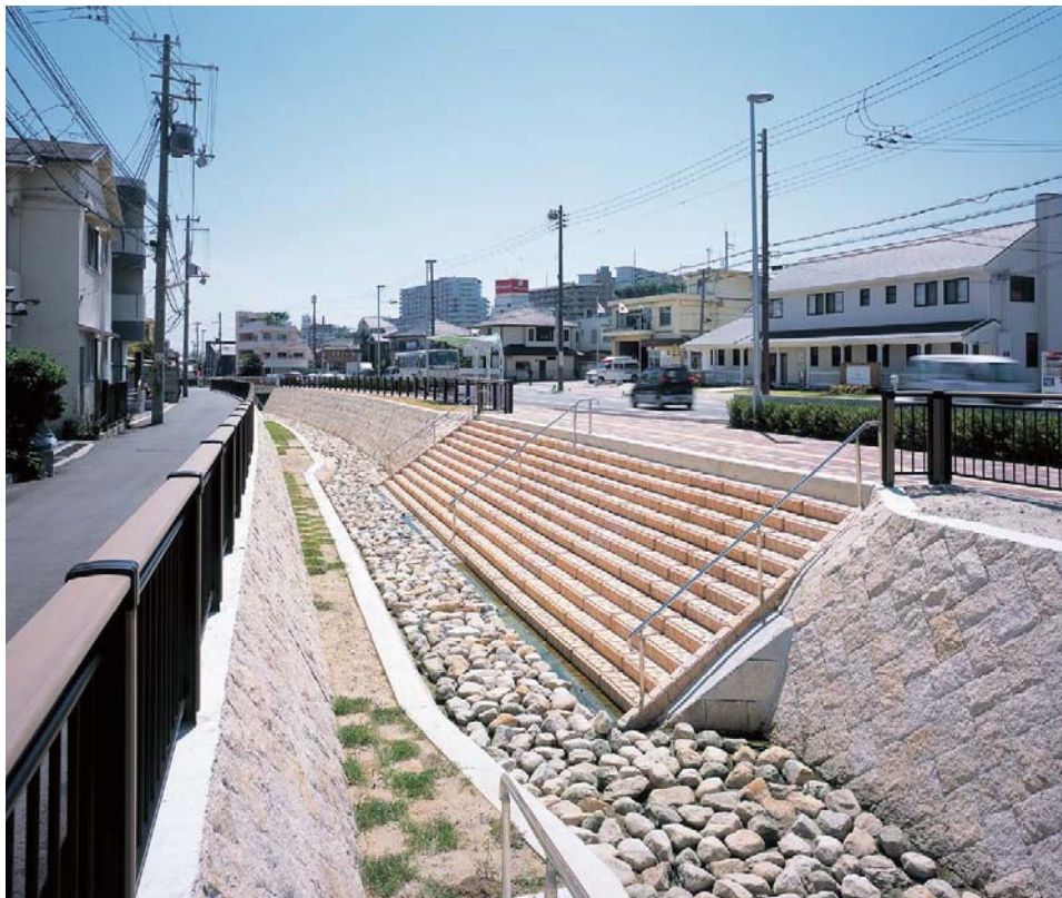
手すりつたいに水辺に降りられる親水型河川。転落防止にリサイクル材の人工木柵が使われています（朝霧川）
