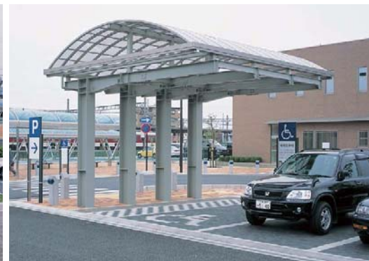
両支持柱は幅 7m、片支持柱は幅 5.5m。鉄骨を用いて、安心して快適な駐車スペースを実現しています(伊勢中川駅東口広場・西口広場)
