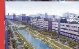
写真-4(上) 東大門付近における施工前の景観。新平和(シンピョンノ)市場屋上から西方を望む 図-3(下) 改修後の将来予測 (提供:ソウル市清溪川復元推進本部)
