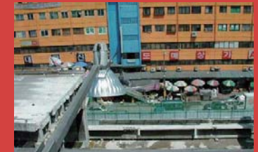
写真-9 東大門市場付近の新平和市場屋上から、進む高架道路撤去工事の足元では、零細露天商たちがバラソルを広げて営業を続けていた
