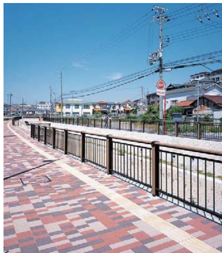
手すりつたいに水辺に降りられる親水型河川。転落防止にリサイクル材の人工木柵が使われています（朝霧川）
