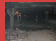
写真-2 廣橋付近の暗渠空間の様子
