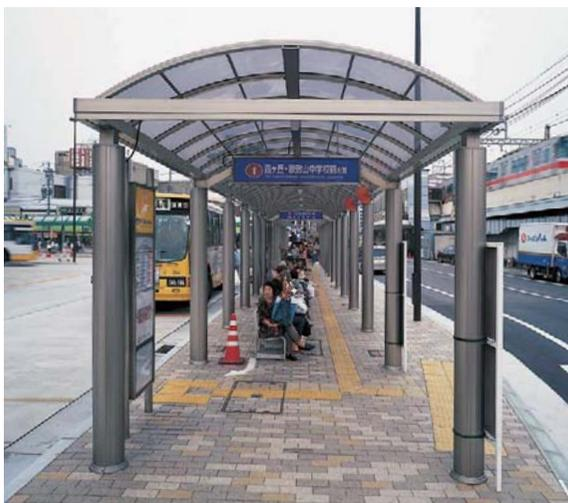
足元が水浸しにならないように、化粧柱内に塩ビパイプを通して、雨水が地中の排水溝に流れるようにしている
