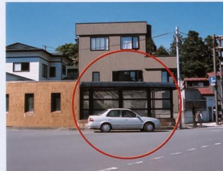
改修後の透明になった地下道入り口
