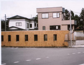
改修前のコンクリートの地下道入り口
