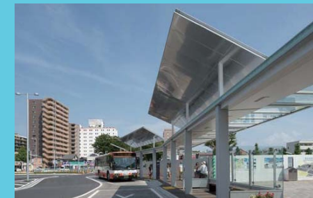
雨の際、乗降時に濡れないよう2段式になっている屋根
