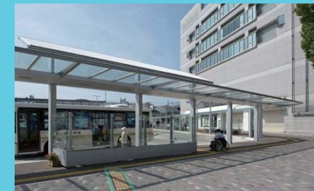
駅前広場はバリアフリーになっている
