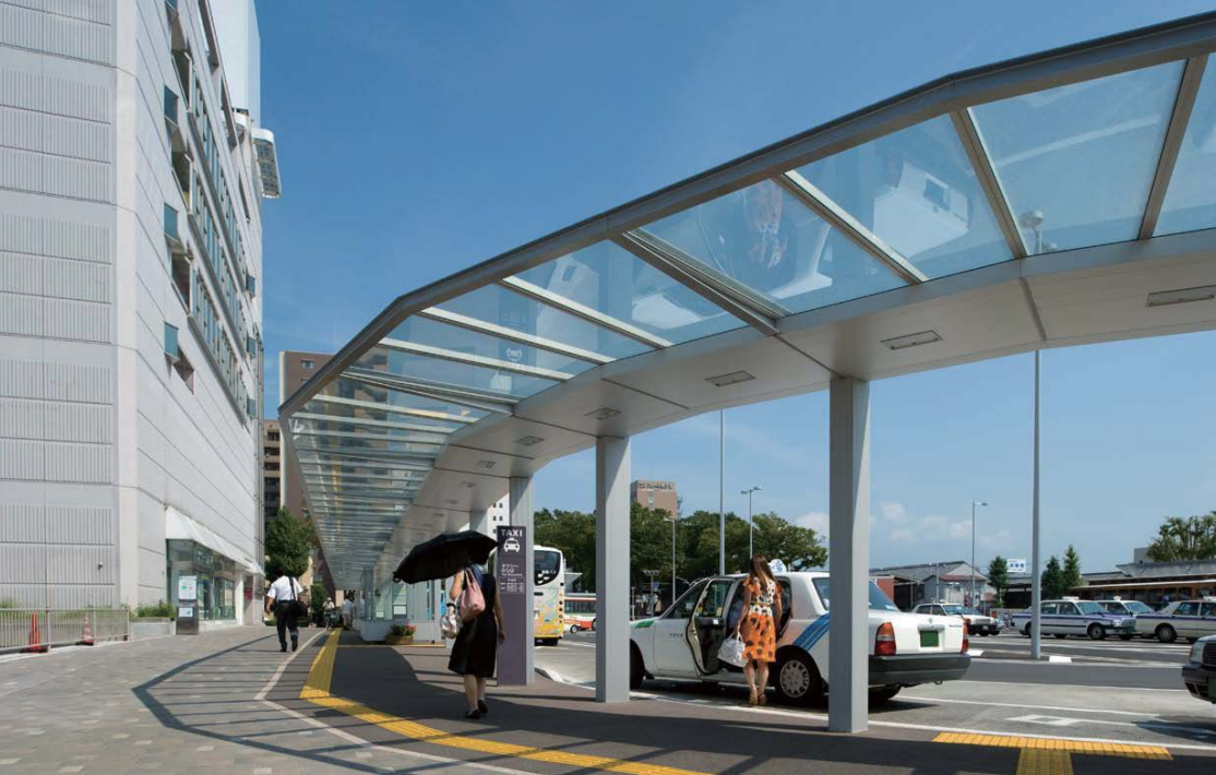
照明のLEDは屋根部分に埋め込むなど、細部にこだわり美しいラインを表現した
