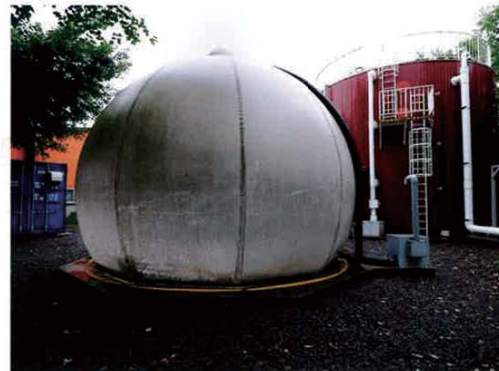
畜ふんバイオマスシステム。円筒形のタンクが発酵槽。ここでメタンガスを発生させ、球体のガスホルダーのため、発電ガスタービンに送られる
