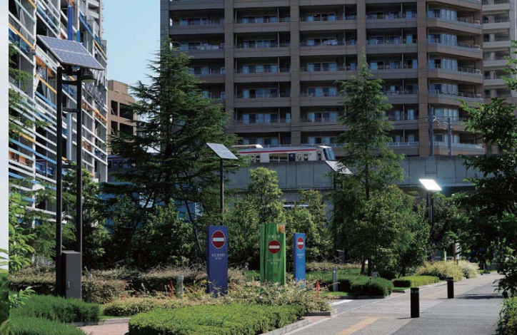
小型発電設備。ららぽーと柏の葉周辺の街路灯は、太陽光発電と風力発電が搭載されている
