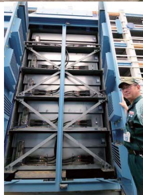
左上 / AEMS(Area Energy Management System)のモニター画面。柏の葉キャンパスのエネルギー状況がひと目でわかり、情報共有できる。AEMSは地域全体の発電量・受電量・消費電量を一元管理するシステム 上右・右 / NAS蓄電池、エリア全体のエネルギー管理・融通を想定した高効率・高性能の蓄電設備。ららぽーと柏の葉における夜間電力有効利用のほか、将来は災害時の非常用電源としても活用する予定
