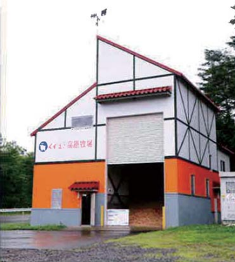
左/くずまき高原牧場内にある木質バイオマスガス化発電施設。現在は実証実験が終了。今後の展開に期待 右/森林整備の過程で発生する間伐材を利用し、チップにして燃料とする
