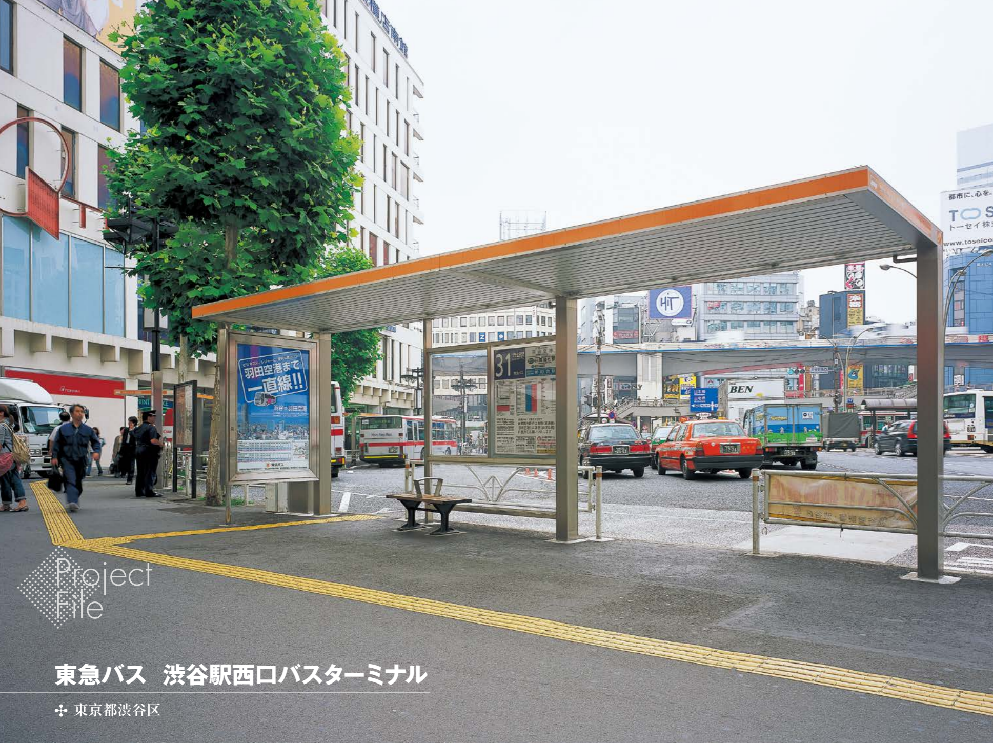
上／新しい4基のバス停は渋谷駅前のロータリー沿いに設置 下／屋根にはアルミを使用。LEDを桁の内側に隠し、新色の「ナチュラルシルバー」で美しい仕上がりに
