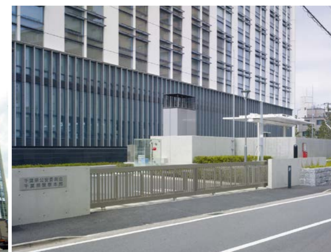
電動式引戸は全部で4基設置してあります
