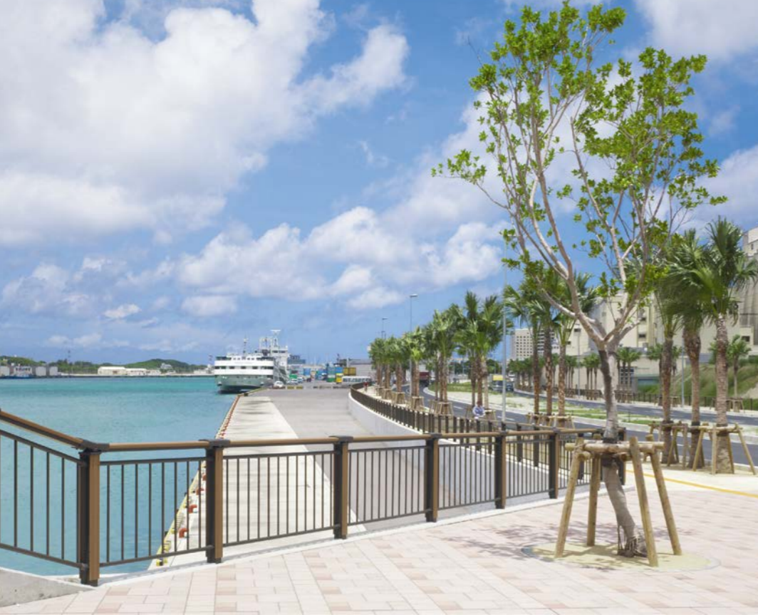
海岸沿いに続く木目調の柵が、気持ちのいい空間を演出しています
