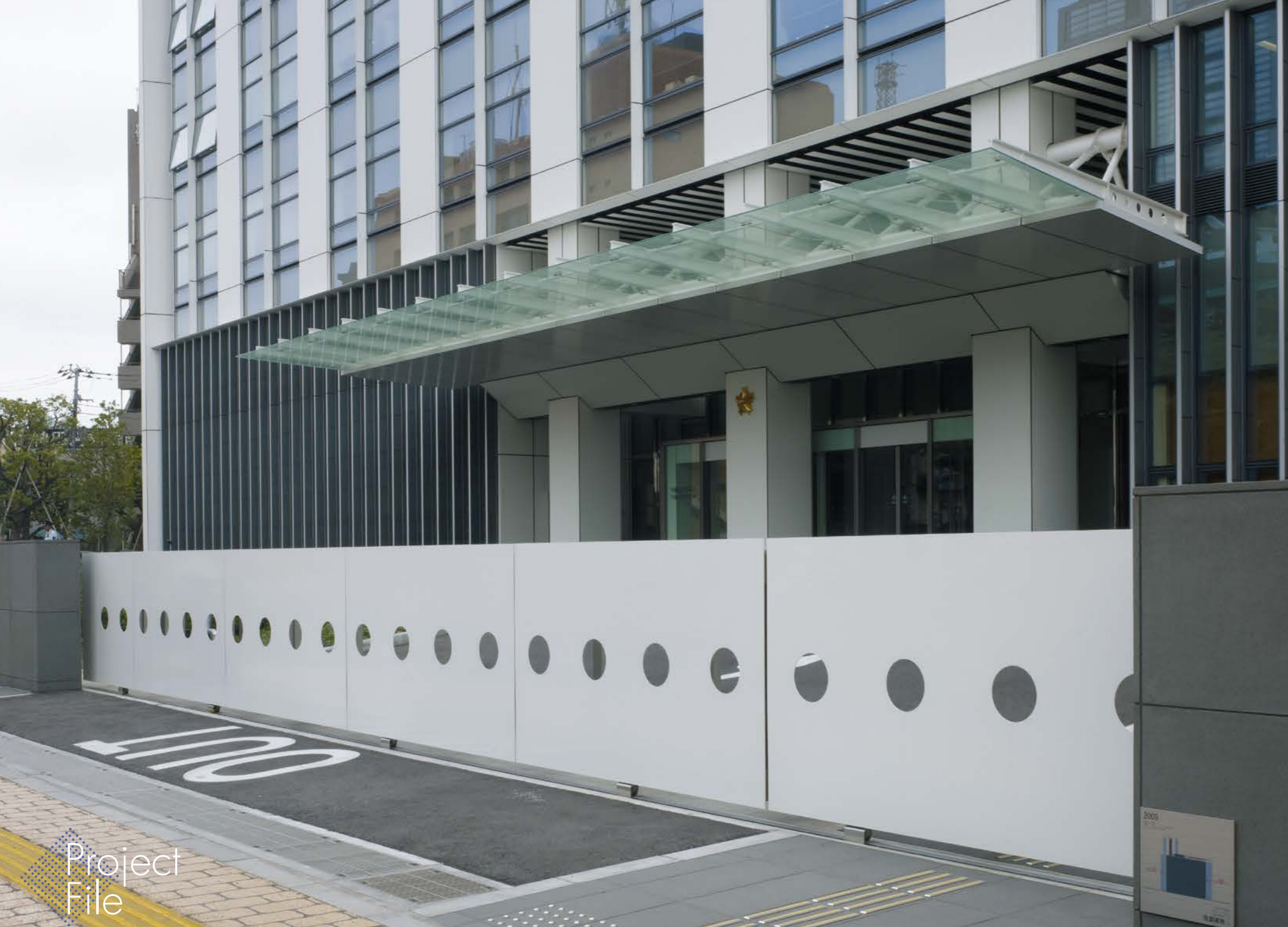
いくつもの円がアクセントになっているデザインパネル。表面はフッ素樹脂塗装で耐久性に優れています
