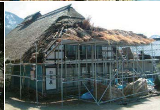
村じゅう総出で屋根のふき替え作業を行う
