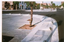
オリンピック村メイン道路の緑石。歩道と車道の段差をなくするため、緑石だけを持ち上げて車の進入を防いでいます
