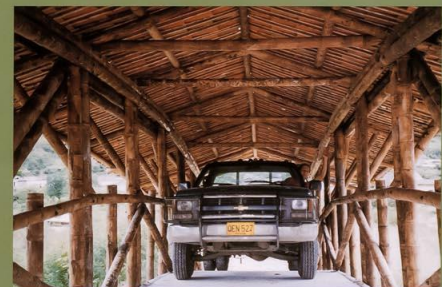
シュタムの竹の橋は、小型トラックが通行できる構造的強度をもっています
