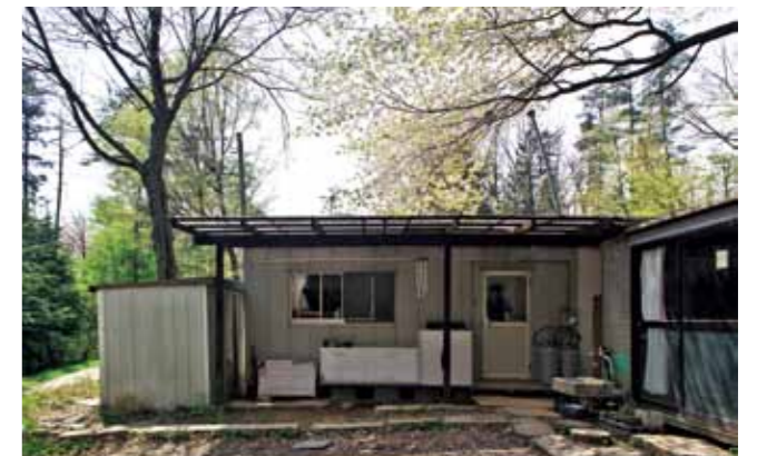
アトリエから住居部分を見る。入口ドア左脇の白い四角の箱は室内側に出入口のある「犬の部屋」
