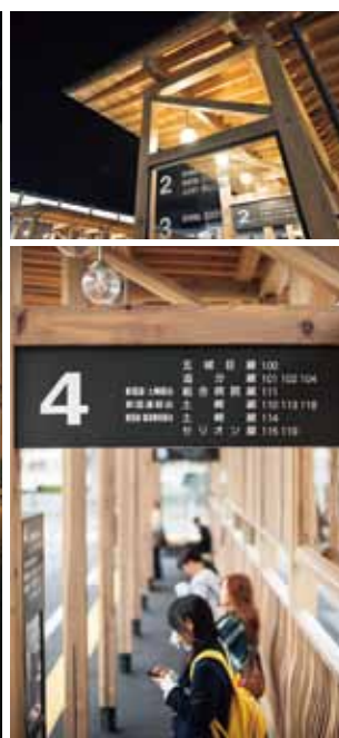
左・右上—秋田杉の美しい木目のバスターミナルがLEDの温かな光と共に夜景に浮かび上がる | 右下—本格的な木構造が力強い[写真3点とも：シブヤスタジオ]
