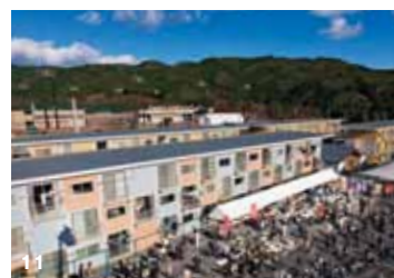
11 坂茂建築設計による女川町の3階建てコンテナ仮設住宅【写真：Shigeru Ban Architects】
