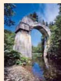
土幌線・第四首更川橋梁 [撮影：西山芳一]
