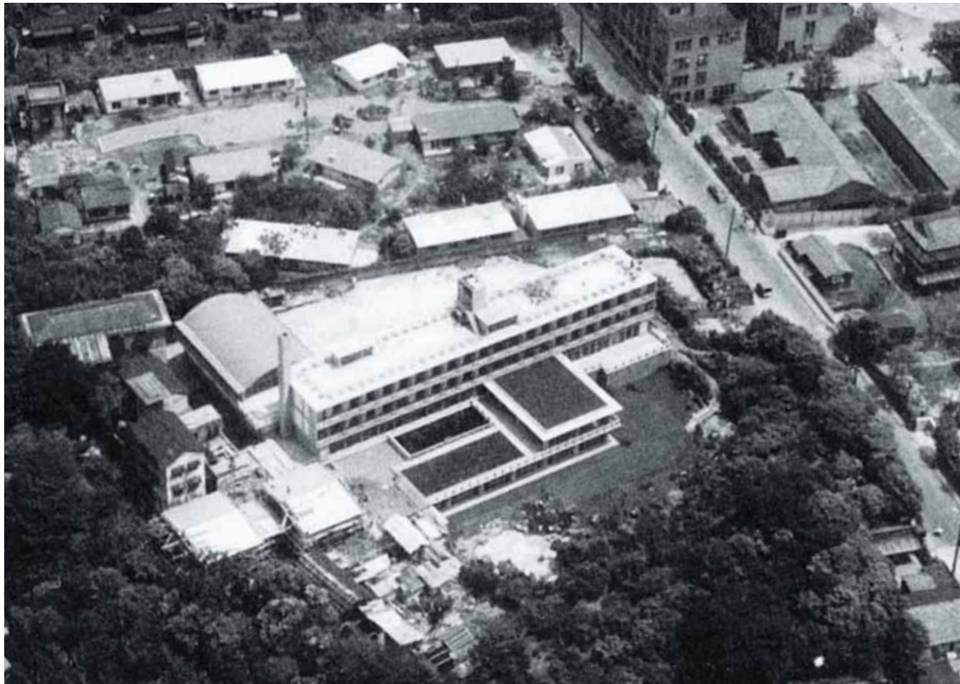
1955年当時の航空写真[提供：国際文化会館] 本館南側・中央部の屋上庭園は竣工時、一部が吹抜けになっており、光庭として機能していた(31頁写真参照)。後に前川國男が改修し、現在は屋上庭園のみ。西側(手前左端)には、本館に接続して2棟の付属住宅があった。吉村順三が設計した理事長とゲストハウスのための住宅である。北側に隣接して建つ3階建ての建物は、岩崎小彌太郎の遺構。東京大空襲の被害から逃れた唯一の建物である[解説：国際文化会館 柳沢洋一]
