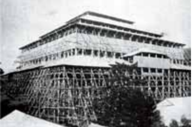
修理工事中の東大寺大仏殿
