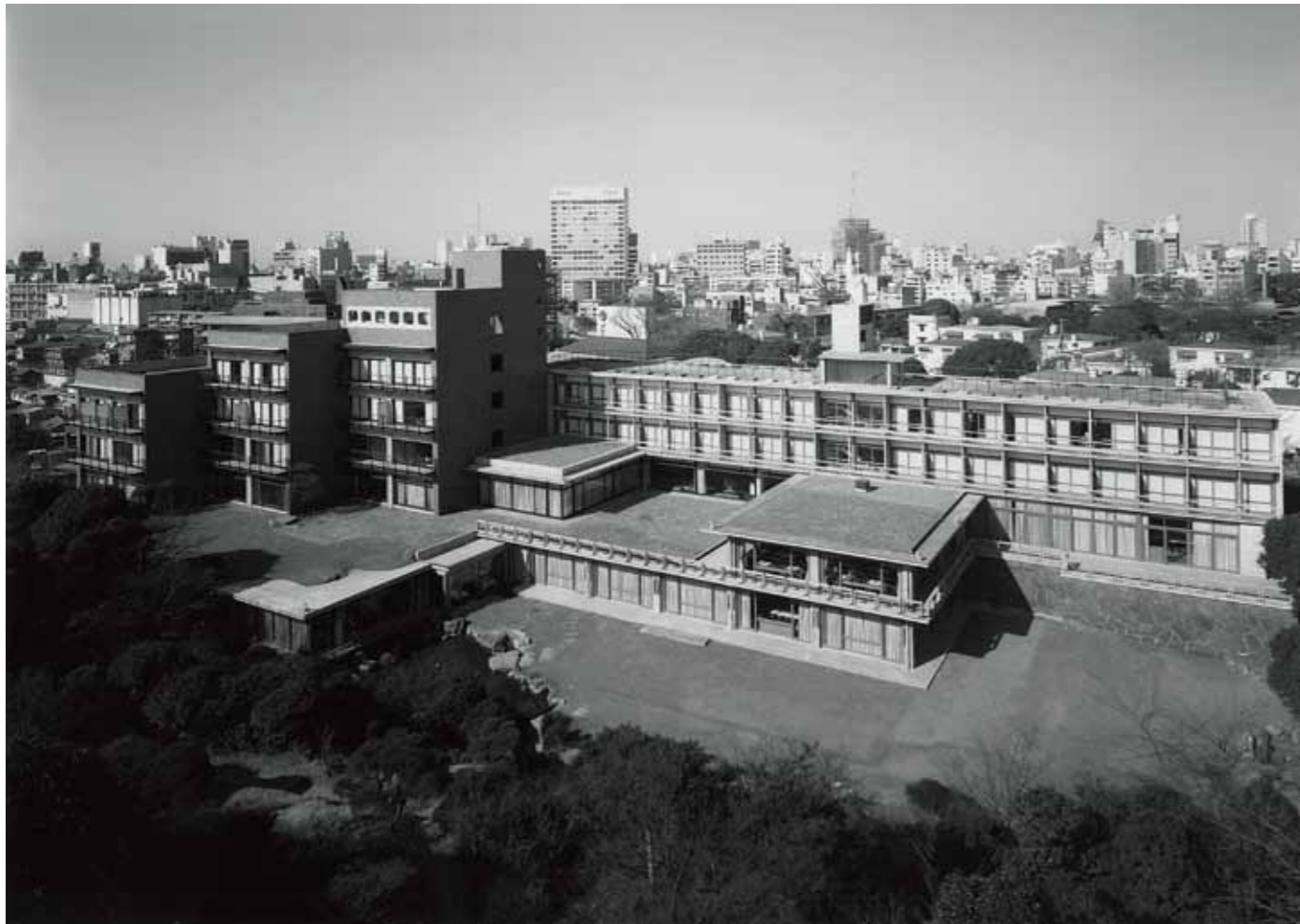
1975年当時の新築された新館【提供：前川建築設計事務所】 竣工以来ラウンジの床を張ったり、中庭を増築したりの改修・増築が行われてきたが、設備の老朽化対応や宿泊機能の充実を図る目的で1975年に大幅な改修・増築を実施。南西側の木造理事長公舎を取り壊し、ここに鉄筋コンクリート造地下2階、地上4階、外観は打込みタイル外壁による新館を建設し、本館の改修は最小限度に止められた。玄関からエントランスホールを通して正面に庭を望む佇まいも、この改修で実施された【解説：橋本功】
