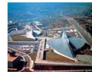
国立屋内総合競技場[1964] [写真：村井修 | 提供：丹下都市建築設計]
