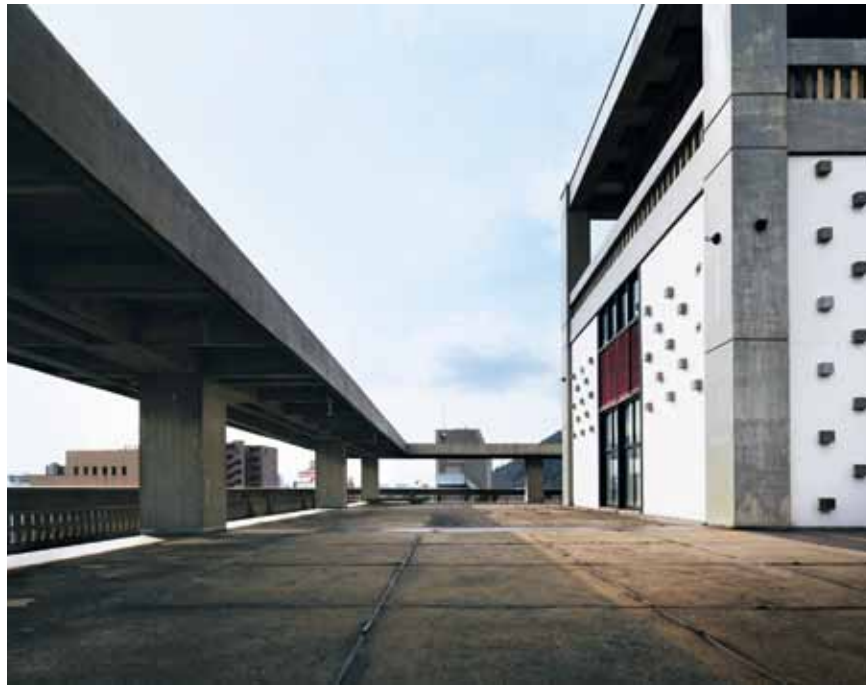
高層棟屋上 「屋上は塔屋を中心に、その周囲を廻廊ぶうの軒によって囲まれたスペースで、(中略)塔屋3階の展望台は市内最高のもので、ここからは市内を眼下に瀬戸内海、四国山脈の山々、屋島などが望まれるのである。竣工以来半年の間に、この屋上には県民の6分の1、十数万の人びとが訪ずれている。市内の人々は折に触れてここに上り、郡部の町や村からは団体がバスを運んで、日に何組となく上ってくる。ここはそれらの人々の、金のかからない手ごろなクリエーションの場所なのである。このような公共のスペースの積極的な導入は、金子県知事以下県当局の強力な支持を受けながら実現した」 [出典：神谷宏治「香川県庁舎について」『新建築』1959.1]
