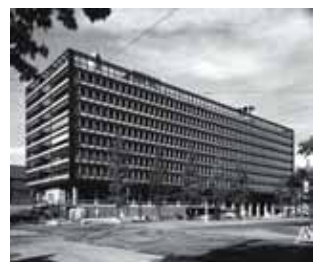
東京都庁舎[1957] [写真: 村沢文雄 | 提供: 丹下都市建築設計]
