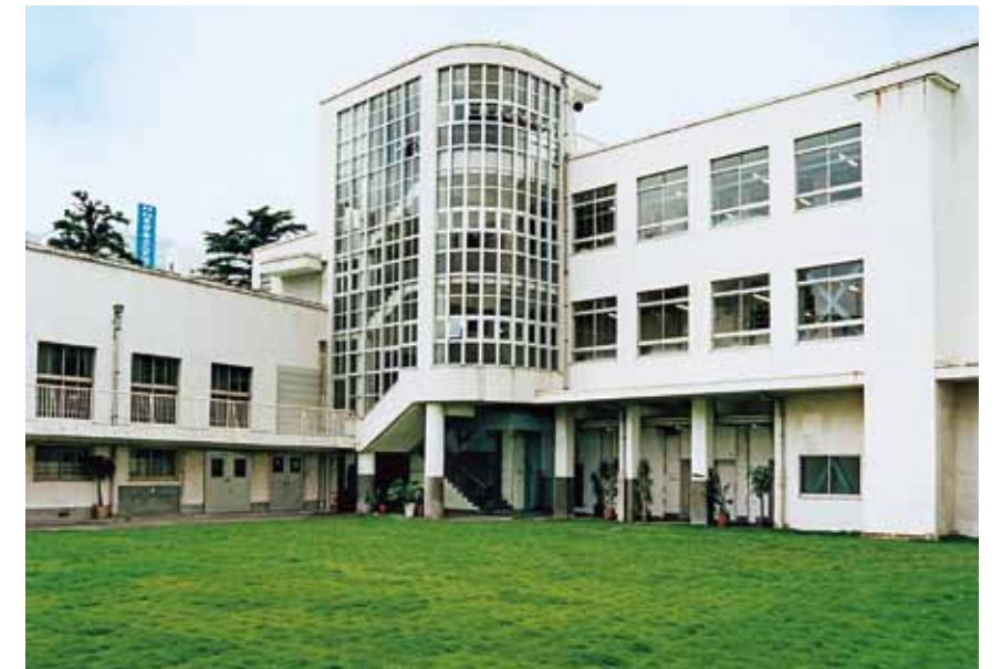
吉本興業東京本部：歌舞伎町に隣接する旧四谷第五小学校をリノベーションした。教室は廊下との壁を取り除き、横につながる開放的な空間にしたことで、社内コミュニケーションが高まったと評判を得ている【提供：吉本興業】
