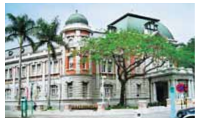
台中州庁(現・台中市政府)【1913】煉瓦造2階建。縦長の伸びやかなプロポーション。マンサード屋根は通風冷却用と考えられる【市定古蹟】【写真：筆者】 台北州庁(現・監察院)【1915】煉瓦造2階建。セセッションの影響を受け、様式の解体と混合が現われている独特な意匠である【国定古蹟】【写真：筆者】 台南州庁(現・国立台湾文学館)【1916】煉瓦造2階建。戦災を受け、最近まで低い勾配屋根だったが、台湾の人々の尽力により、豊かな影りみのマンサード屋根やドームが戦前の姿に復元された【国定古蹟】【提供：トリップアドバイザー】
