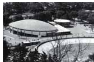
愛媛県民館[1953] [写真: 平山忠治 | 提供: 丹下都市建築設計]
