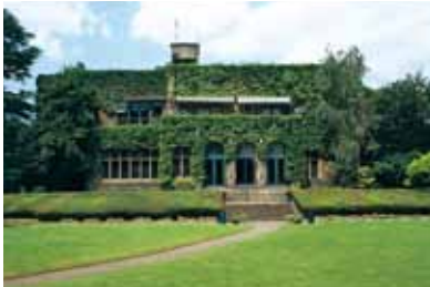
蜂須賀侯爵邸 [1927] RC造2階建。外観はツタに覆われ細部意匠はよく分らなかったが、内部は極めて保存状態が良かった。昭和62年に解体された[写真：筆者]
