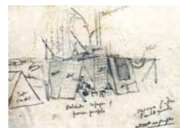
濃尾地震のスケッチ | コンドルは濃尾地震が起きた時、丸の内の開発計画を立案中であった。三菱に縁の深い外国商人グラバーらは、コンドルに濃尾地震を調査させることを三菱幹部に進言、コンドルが派遣された。彼は諸所でスケッチをし、日本建築学会で報告を行っている。コンドルはレンガ造を固く剛構造に固めることで耐震性を増そうと考えたようである。彼はレンガ積みの中に帯鉄を敷き込んで耐力を増す方法を採用している。レンガ造は重いので1階部分は重しが効いて崩れにくく、上階部分が倒れやすい。それに対して本造は屋根瓦が重かつたりすると、1階部分が押しつぶされてしまう。壊れ方が対照的なのである。関東大震災後、レンガ造建築では、最上階の取り壊しも行われている [所蔵:東京大学工学部建築学科]
