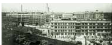
日本赤十字大阪支部病院 | RC造4階建ての大規模病院建築で、1929-34年にかけて数次に分けて建築された[出典:『近代建築画譜』]
