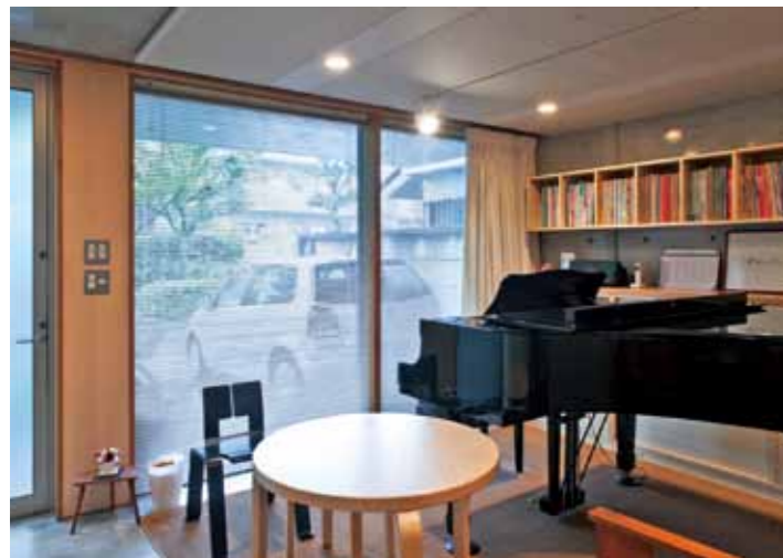
玄関脇にある志乃さんのピアノ室。天井の吸音ボードと床の吸音敷物を施工して、ピアノ室は2年前に完成。家は刻々と変化⇒進化している
