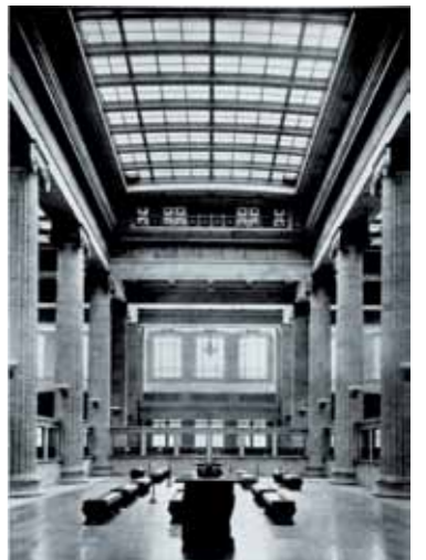
日本勧業銀行本店 | 上—外観★/下—営業室★ 銀行建築は様式建築を表現する上で最も適当な建築といわれていた時代、渡辺節はその優れた感性によって、この建物を自他共に認める代表作に仕上げた
