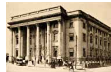
朝鮮銀行本店 | 上——竣工当時【出典：『営業経歴』】/下——2009年現在【写真提供：筆者】 漢城(京城、ソウル)の中心地に建てられた2階建て(一部3階建て)のルネサンス様式の建物。起工時には第一銀行韓国総支店だったが、定礎から3ヵ月後の1909年10月に韓国銀行本店となり、工事途中の1911年8月には朝鮮銀行本店となった。構造はRC造の床を石造と鉄骨レンガ造の柱で支える混構造。戦後は韓国銀行本店として使われていたが、現在は、韓国貨幣金融博物館に転用され、銀行業務は後方の高層棟に移転している
