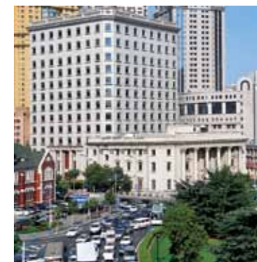
朝鮮銀行大連支店 | 上——竣工当時【出典：『営業経歴』】/下——2009年現在【写真提供：筆者】 大連の中心地である大広場(現・中山広場)に面して建てられた鉄骨レンガ造の建物。前面にはコリント式のジャイアントオーダーが6本並ぶ。内部は、営業室部分が吹抜けになっている。1990年代に後方に新館を増築し、この建物は2001年、国家重点文物保护单位(国の重要文化財に相当)になった
