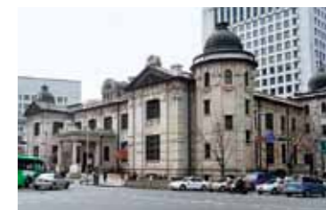
朝鮮銀行本店 | 上——竣工当時【出典：『営業経歴』】/下——2009年現在【写真提供：筆者】 漢城(京城、ソウル)の中心地に建てられた2階建て(一部3階建て)のルネサンス様式の建物。起工時には第一銀行韓国総支店だったが、定礎から3ヵ月後の1909年10月に韓国銀行本店となり、工事途中の1911年8月には朝鮮銀行本店となった。構造はRC造の床を石造と鉄骨レンガ造の柱で支える混構造。戦後は韓国銀行本店として使われていたが、現在は、韓国貨幣金融博物館に転用され、銀行業務は後方の高層棟に移転している
