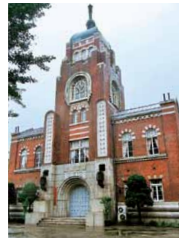
天道教中央教会 | 2009年現在。天道教は、朝鮮半島在来の民間信仰に、仏教と道教が融合して成立した宗教である。この建物は、その総本山として第3代目の代表を務めたソン・ビョンヒ(孫秉熙)が計画し、中村建築事務所が設計したもの。建物の後方部分には、折り畳み椅子で400席が並ぶ講堂がある。フェラーが設計を担当したと伝えられる[写真提供:筆者]
