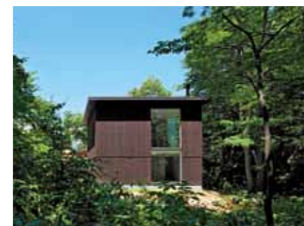
夏期、森越しに遠望する建物。焦げ茶色の外壁は塗装ではなく、唐松の羽目板を燻煙処理したもの。建物のそばに寄り寄り、玄関に入った瞬間など、どこからともなく美味しそうなスモークハムの匂いがする
