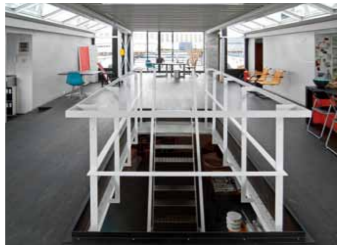
室内の中央部に吹き抜けがあり、仕事場に降りる階段が新設された。吹き抜けはもともと機関室からエンジンその他の機械類を撤去・搬出するために開けた「穴」。鉄骨階段が、見るからに船舶的なデザインになっているところがニクイ
