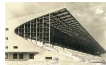
上——旧山口吉郎兵衛邸(現・滴翠美術館)※ | 芦屋市に所在。戦後は滴翠美術館となった(建物内部は、美術館展覧中の展示室を除き、非公開)。南を正面として、東側にL型の洋館、西側に木造平屋の和館が並立する。2階部分に旧宅の座敷を内包するなど建築主の複雑な希望も容れつつ、卒業設計以来の伝統住宅の再解釈を果たす 中——南満洲鉄道株式会社東京支社※ | 黒御影・白御影・クリーム色タイルの3種類の外装材によって壁面を分節する。その硬質な表情からは、大阪ガスビルからさらに新しいファサード表現に踏み出したことがうかがえる 下——日本競馬会京都競馬場※ | 戦前期最後の大建築。コンベによって獲得した。鉄骨構造による23mに及ぶ片持ち梁とそこから吊り下げられた特別観覧席の緊迫感、近代日本の構造表現の中でも特筆に値する
