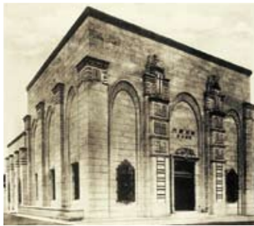
野村銀行京都支店 | 四条通りに異彩を放っていた。柱型の形態の奇妙さとどまらず、その間のアーチは放物線をなし、追線は傾斜がつくといったように、造形は奔放を極める[出典:「自由様式への道—建築家安井武雄伝」]
