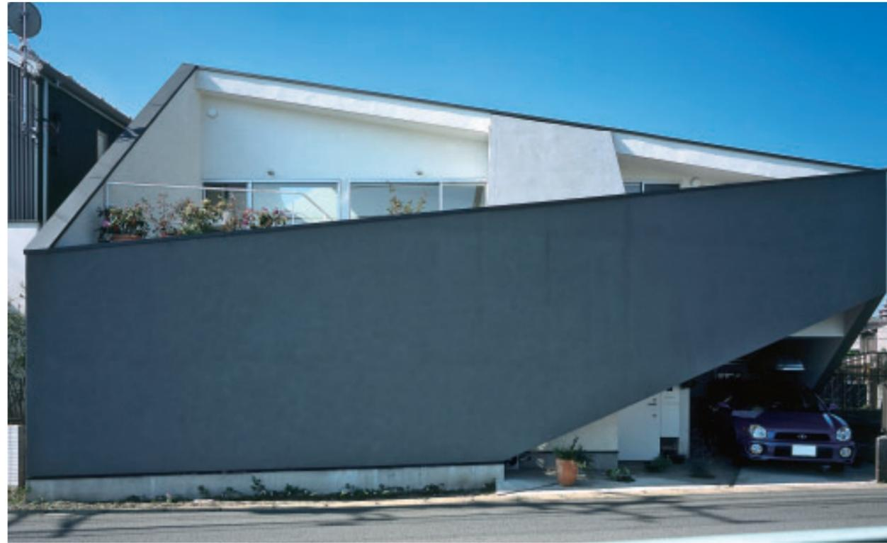
東面全景 道路側の壁が音と光の反射板として働く
