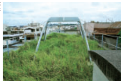
屋上テラスは、断熱効果が高めるためイネ科の干茅（ちがや）で緑化されている
