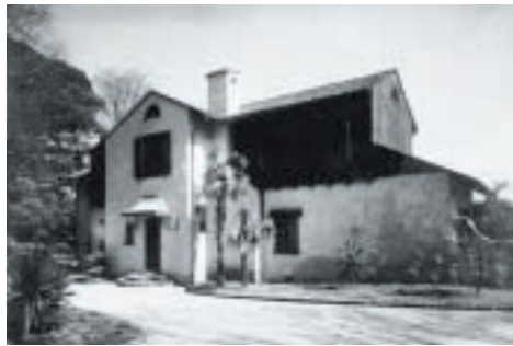
瀬田勢吉邸（1935）スパニッシュ様式の邸宅。傍軒の出ない切妻、外壁と同じ仕上げの屋根付きの煙突、コテ跡をわざと残した塗り壁、外壁から突き出して並ぶ梁の頭、入り口上部のキャノピーを支えるスクロールした持送り、テラスから外階段で上がるバルコニー、これらはスパニッシュ様式の要素である。当時、日本のスパニッシュ様式の流行は既に下火で、シンプルな簡易版が普及していた。そんな日本のスパニッシュ建築史の流れとは全く関係なく、アメリカ直伝の姿で現れた。建築主の瀬田勢吉は、軍平と同じ1923年にコーネル大学工学部を卒業しており、軍平とはその頃からの知り合いであろう
