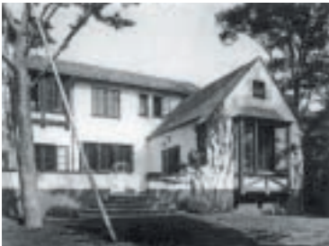
瀬田勢吉邸（1935）スパニッシュ様式の邸宅。傍軒の出ない切妻、外壁と同じ仕上げの屋根付きの煙突、コテ跡をわざと残した塗り壁、外壁から突き出して並ぶ梁の頭、入り口上部のキャノピーを支えるスクロールした持送り、テラスから外階段で上がるバルコニー、これらはスパニッシュ様式の要素である。当時、日本のスパニッシュ様式の流行は既に下火で、シンプルな簡易版が普及していた。そんな日本のスパニッシュ建築史の流れとは全く関係なく、アメリカ直伝の姿で現れた。建築主の瀬田勢吉は、軍平と同じ1923年にコーネル大学工学部を卒業しており、軍平とはその頃からの知り合いであろう
