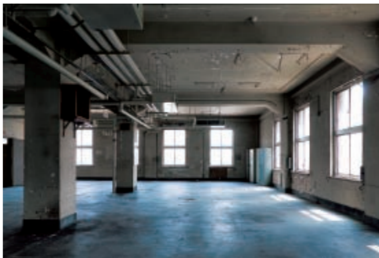
2階オフィス空間 建物の外周をぐるりと窓が並んでいること、当時の事務所建築にしては階高が高く、壁から天井まで白く塗られているため、内部のオフィス空間は均一に明るい
