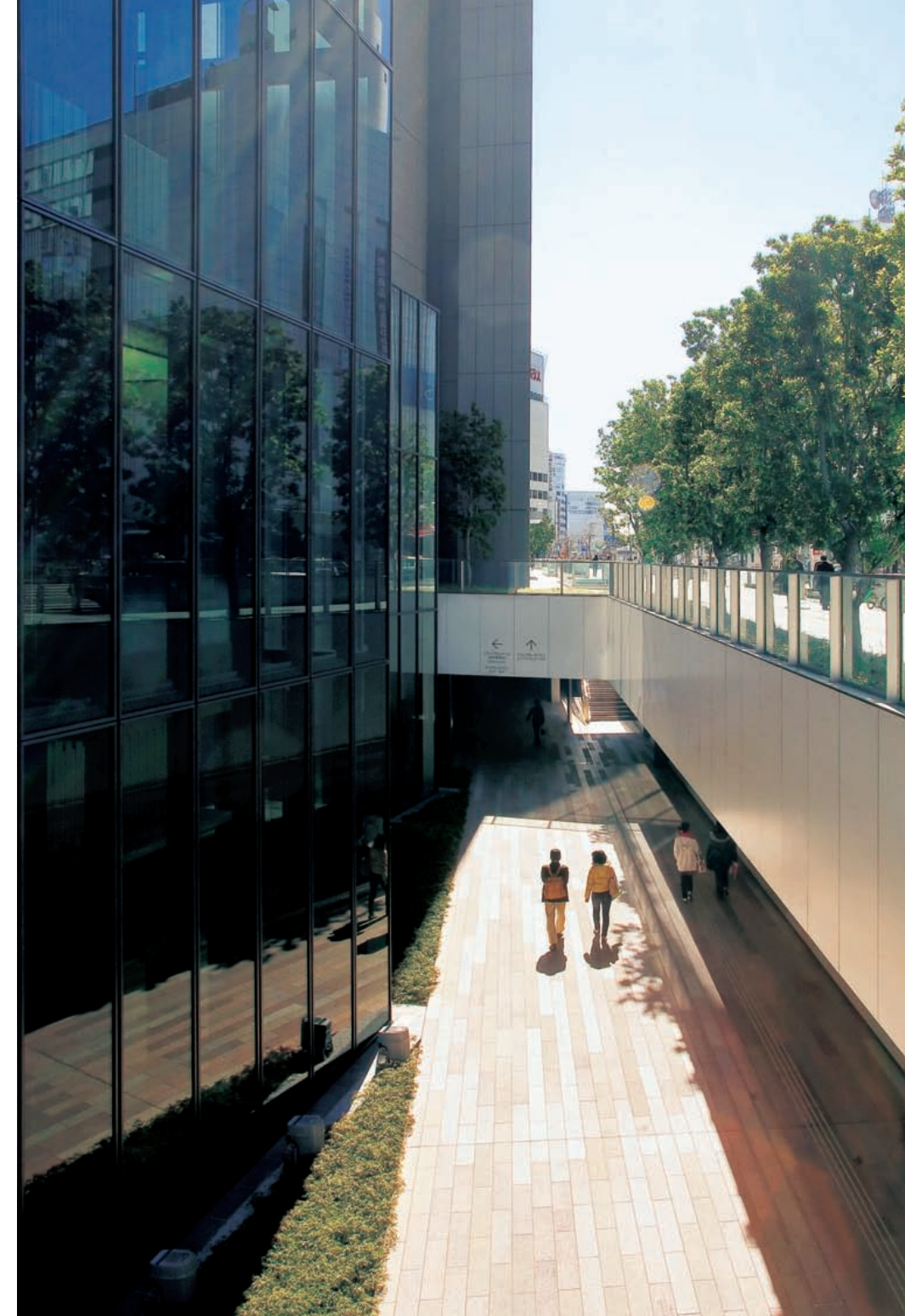
上—ミッドランドスクエア サンクンガーデン 地下街の混雑緩和や安全性確保のために有効なバイパス通路 下—同 無機的になりがちな空間の一角にある立体的な花壇
