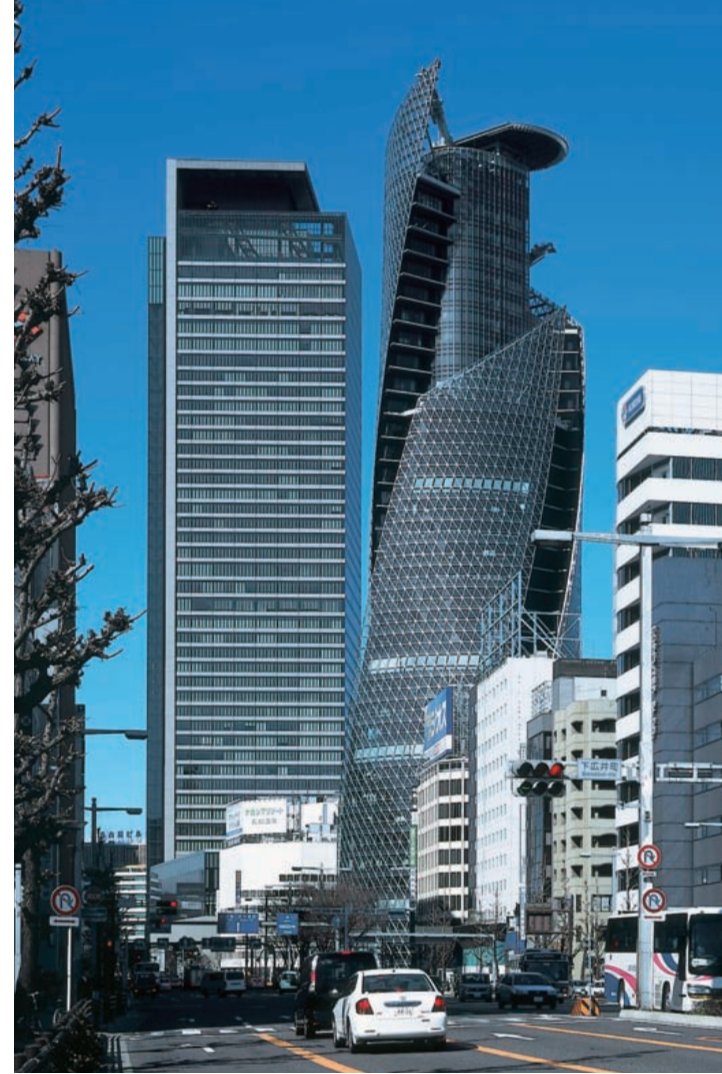
モード学園スパイラルタワーズとミッドランドスクエアを南側から見る。デザインの指向は全く異なるものの、ともに高質なファサードの競演が、ひとつの街並みの中で都会らしい緊張感と調和を生んでいる
