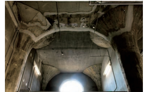
上—操作廊の端部の地上階（地下1階）にある、コンクリート打放しのコラム。オリジナルの型枠の様子が残る唯一の柱で、同一形状の細長い小割り板を駆使してパラポラ（放物線）状の回転体を構成していたことが分かる 下—地下2階の倉庫内のコラム。高さ6m以上のコラムが林立する様子は、エジプトの神殿を彷彿させる。ただし、これらのコラムの型枠は化粧としてデザインされていない
