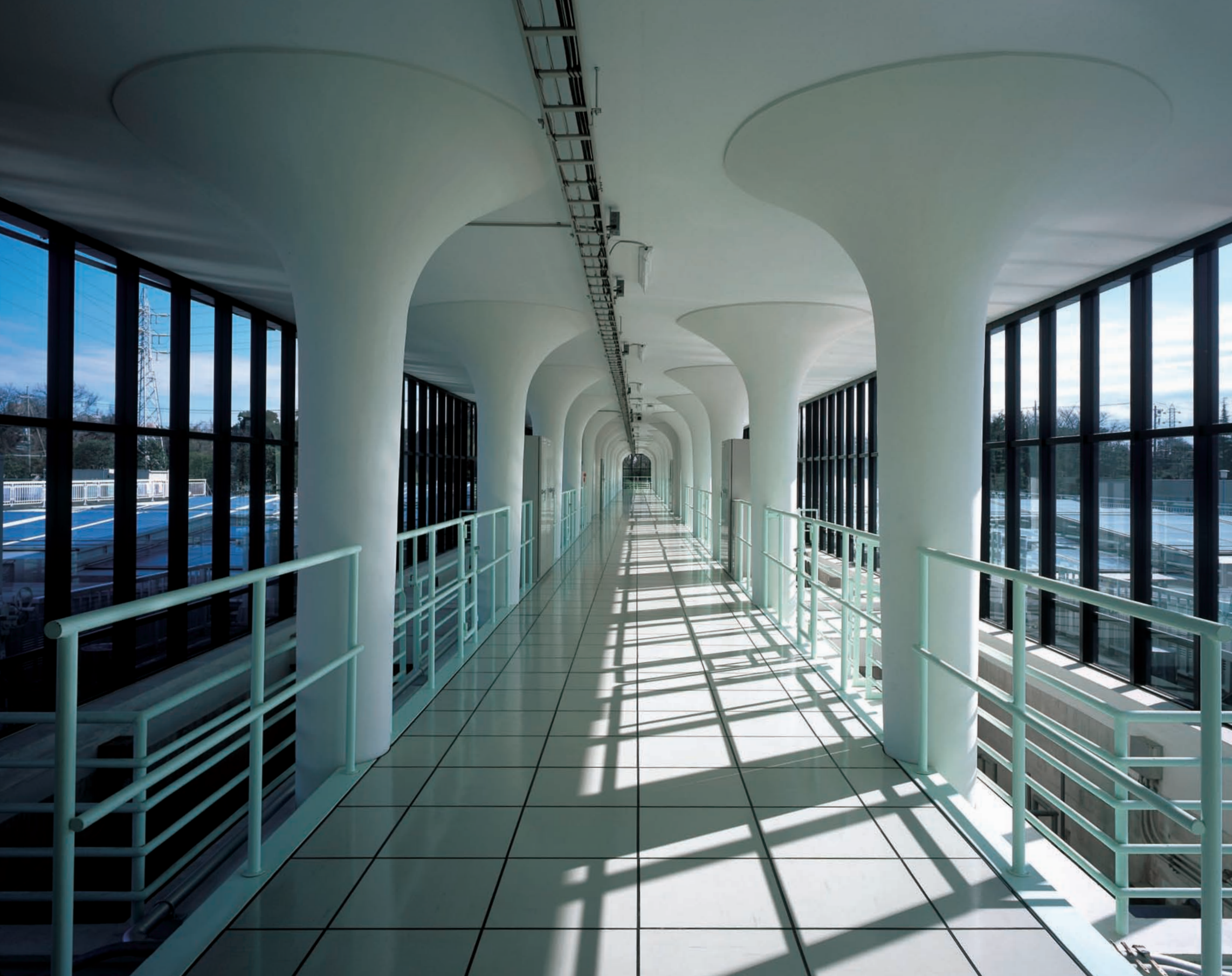
1階操作廊内部 2007年の大改修で内部の柱の表面はすべてホワイトに再塗装されたが、オリジナルはグレー系の艶のあるカシュー塗りであったと思われる。すべてのコラムには雨樋が打ち込まれており、詰まることなく現在まで使われている
