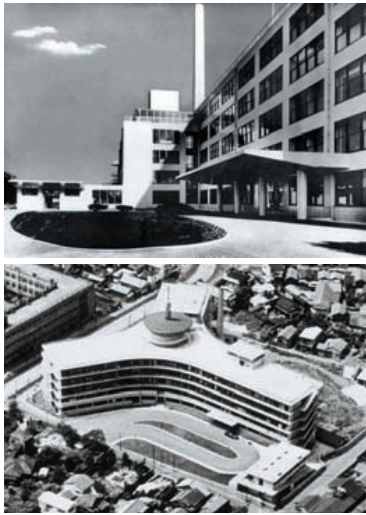
上—東京通信病院（1937）民間企業と通信省職員の寄付金によって、通信省が自前で建てた大病院。規格サイズの建物棟を平行配置しクラスター状につなげることで、均質かつ十分な採光と通風が確保され、増築に対しても容易に可能なシステムとなっている 下—東京厚生年金病院（1953）Y字の中央部に垂直動線やコモンスペースなどを集約し、翼部に各病室を設けることで、集中管理方式を採用している。また逆梁スラブを採用することで、バルコニー側の開口部を天井いっぱいまで設けているなど、構造上の工夫がされている （写真2点とも：東海大学学術資料センター所蔵）
