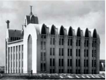
東京中央電信局（1925）通信建築史上、パイプ的存在の建物。流水防火装置の設置、気送管システムの導入、外壁柱を空調ダクトとして兼用するなど、当時としては超ハイテク建築であった（NTT建築総合研究所蔵）
