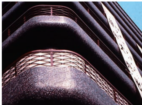
京都タワービル（1964）高さ31mの鉄骨鉄筋コンクリート造のビルの上に、高さ100mの鉄板構造（=応力外被構造）のタワー（法令上は屋上工作物）が載った建物。ビル部とタワー部の接合部分には、8本の鉄骨柱が使われている。タワーは設計構想の途中、施主の要請で付け加えられた。竣工当初、ビル部の外壁を覆うバルコニー庇の軒裏には、23mm角の紫色の泰山タイルが張られていた（写真下：大阪山田守建築事務所所蔵）
