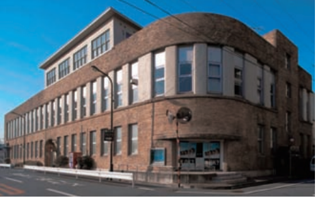
東京中央電信局（1925）通信建築史上、パイプ的存在の建物。流水防火装置の設置、気送管システムの導入、外壁柱を空調ダクトとして兼用するなど、当時としては超ハイテク建築であった（NTT建築総合研究所蔵）
