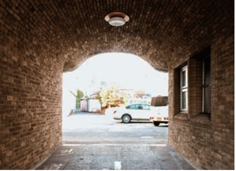
千住郵便局電話事務室（1929）通信省時代で現存する数少ない山田作品のひとつ。角地のコーナーの位置にアールのついたエントランスを設けるスタイルは、その後の特定郵便局のプロトタイプともいえる。2階の縦長窓を水平連続に見せる表現には、アムステルダム派の影響がうかがえる。トンネル状のサービス通路内のスクラッチタイルの壁面は、中庭側に付けられた庇の軒先まで途切れることなく連続している
