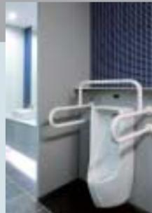
男子トイレ ●INAX使用商品●小便器：U-406RCD、手すり：KF-701E、洗面器：L-531、水栓金具：AM-90 (100V)、水石けん入れ：KF-24DM
