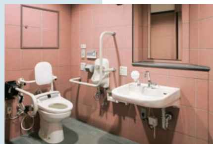
多目的トイレ ●INAX使用商品●大便器：C-5KR、フラッシュバルブ：OKC-581,OKC-2BT、洗面器：L-365APRS、自動水栓：AM-500K (100V)、水石けん入れ：KF-24BN、手洗器：AWL-71AP (P)、背もたれ：KFC-270T1トク、紙巻器：CF-A63S、鏡：KF-4590A、シャワートイレ：CW-E45-CK
