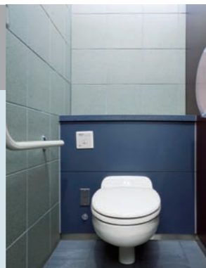
男子トイレ ●INAX使用商品●洋風便器：C-26UCDT、隠ぺい型自動FV：OKC-581-TU1、タッチスイッチ：OKC-2BP-TU1、普通便座：CF-39AK
