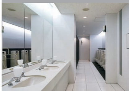
男子トイレ ●INAX使用商品●洗面器：L-2094FCS、自動水栓：AM-91K (100V)、水石けん入れ：KF-24B、センサー体形小便器：AWU-506R
