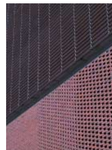
上—本社商談室吹抜け 左下—外壁詳細 右下—店舗階段部吹抜け。スチールカーテンウォールが支持する透かし積みレンガ
