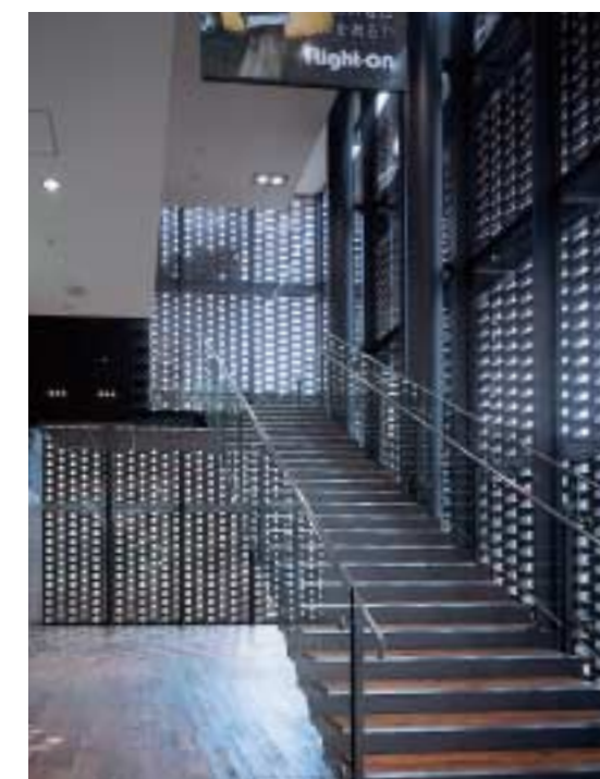
上—本社商談室吹抜け 左下—外壁詳細 右下—店舗階段部吹抜け。スチールカーテンウォールが支持する透かし積みレンガ
