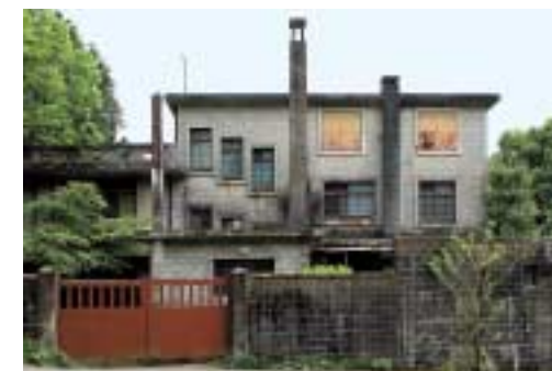
北面外観 階段室の窓が階段に沿って配されており、モダニズムに特有の非対称的なデザインとなっている。暖炉などのための細い煙突が造形的なアクセントを与えていて面白い
