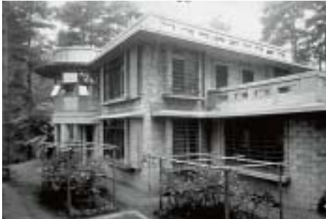
鶴巻鶴一郎 竣工当時の写真。窓や建物上部に庇が取り付けられているのが分かる（写真所蔵：栗原博典）
