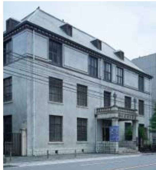
左—正面（南面）外観 装飾が排され窓の浅い巨大な壁面や、3階隅部の枠取りがなく側面に回り込んでいる壁面のデザインなどに、モダニズムの方法が見られる 右—屋内階段 手摺子はきめ細かい繊細なデザインだが、きちんと幾何学形態が用いられている。この建物の窓サッシは大部分が竣工後に取り換えられ、デザインが変更されているが、この写真の上部に写っている窓サッシは、竣工当時のままのもの
