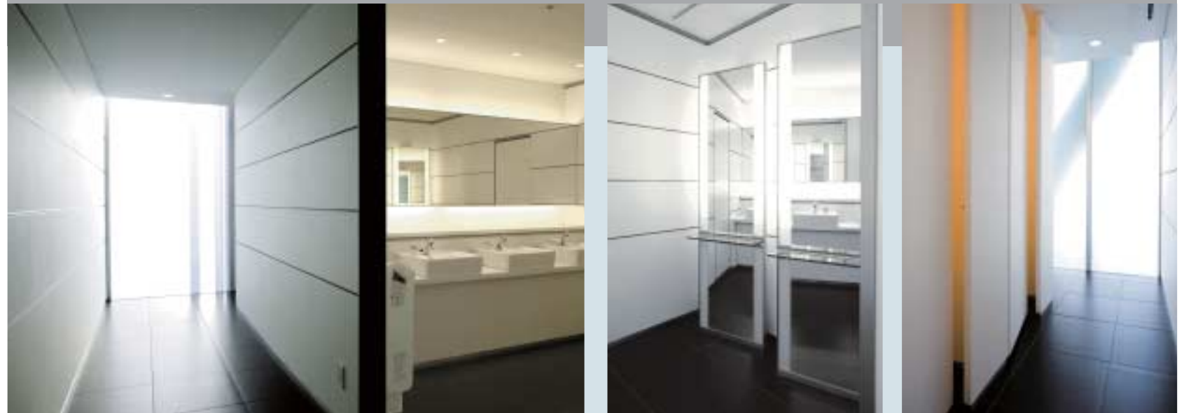
女子トイレ ●INAX使用商品●サティス洗面器：L-533-TK1（120）、サーモスタッド付自動水栓：AM-90KトクAM-93、水石けん供給栓：KF-114BL-Z1
