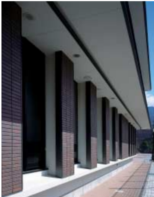
上—東面全景 左—外壁近景 タイル張りの外壁面に凹凸を設け、その陰影によって壁面の長大感を軽減している 右ページ—2階音楽室前からチャペルコートを見る。円筒形のボリュームは階段室。遠方に比叡山望む
