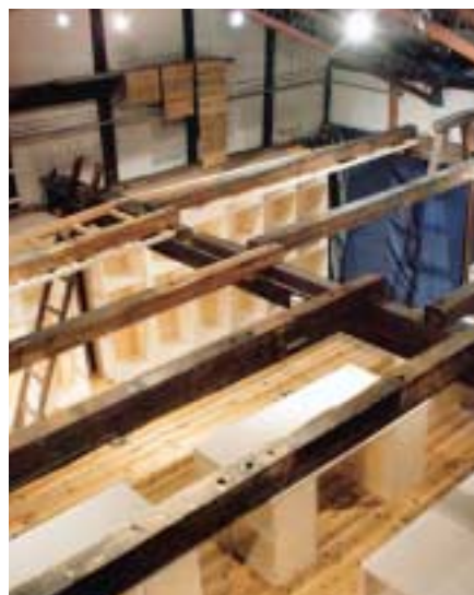
ローバー都市建築事務所オフィス
