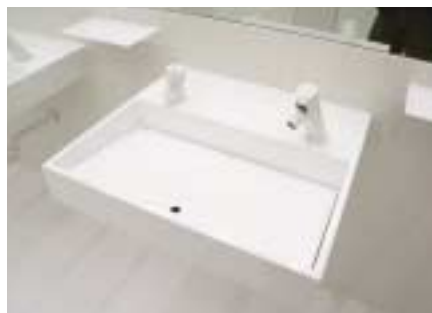
手洗器 SUS t=1.5にプールの水槽に使用するアクリルシリコン塗装剤を塗布。手洗器に合わせて自動水栓と水石けん入れも白く塗装
