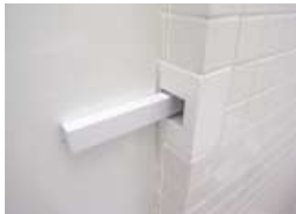
ラッチ 50角タイルに合わせて製作。ラッチが壁に入り込む形になっている
