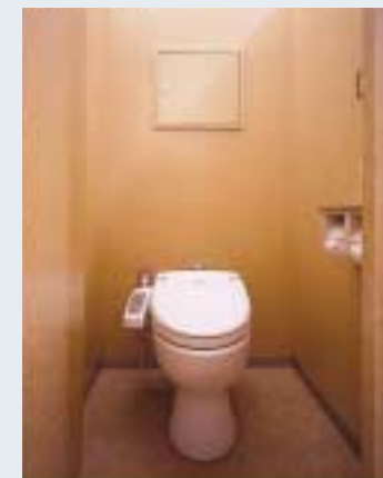
女子トイレ ●INAX使用商品●シャワートイレ：CW-P12F-NE、大便器自動洗浄システム：C-5R、自動フラッシュバルブ（埋込形）：OKC-581、タッチスイッチ：OKC-2BP
