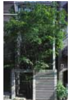
これ見よがしなところはまるでなく、うっかりすると通り過ぎてしまうほど清楚で控えめなたずまい
