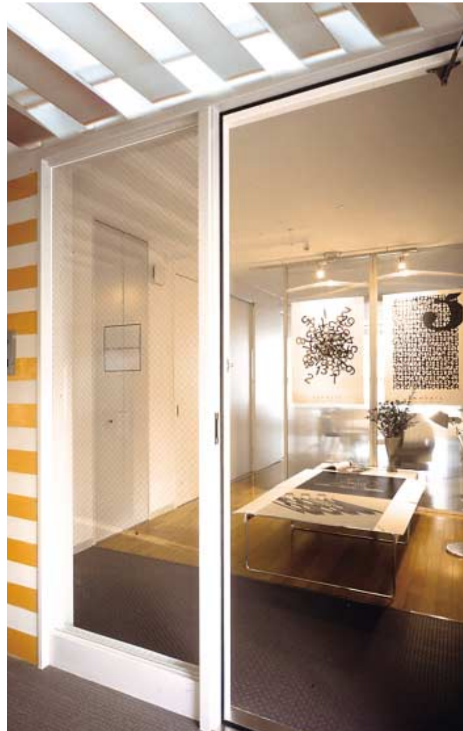
中廊下に向けてガラス張りのエントランスが設けられた“ベーシックユニット”。玄関を入った所はさまざまな用途に利用できるよう、広いスペースが確保されている。住戸内に見えるスクリーンは可動式で、自由に空間を仕切ることが提案されている
