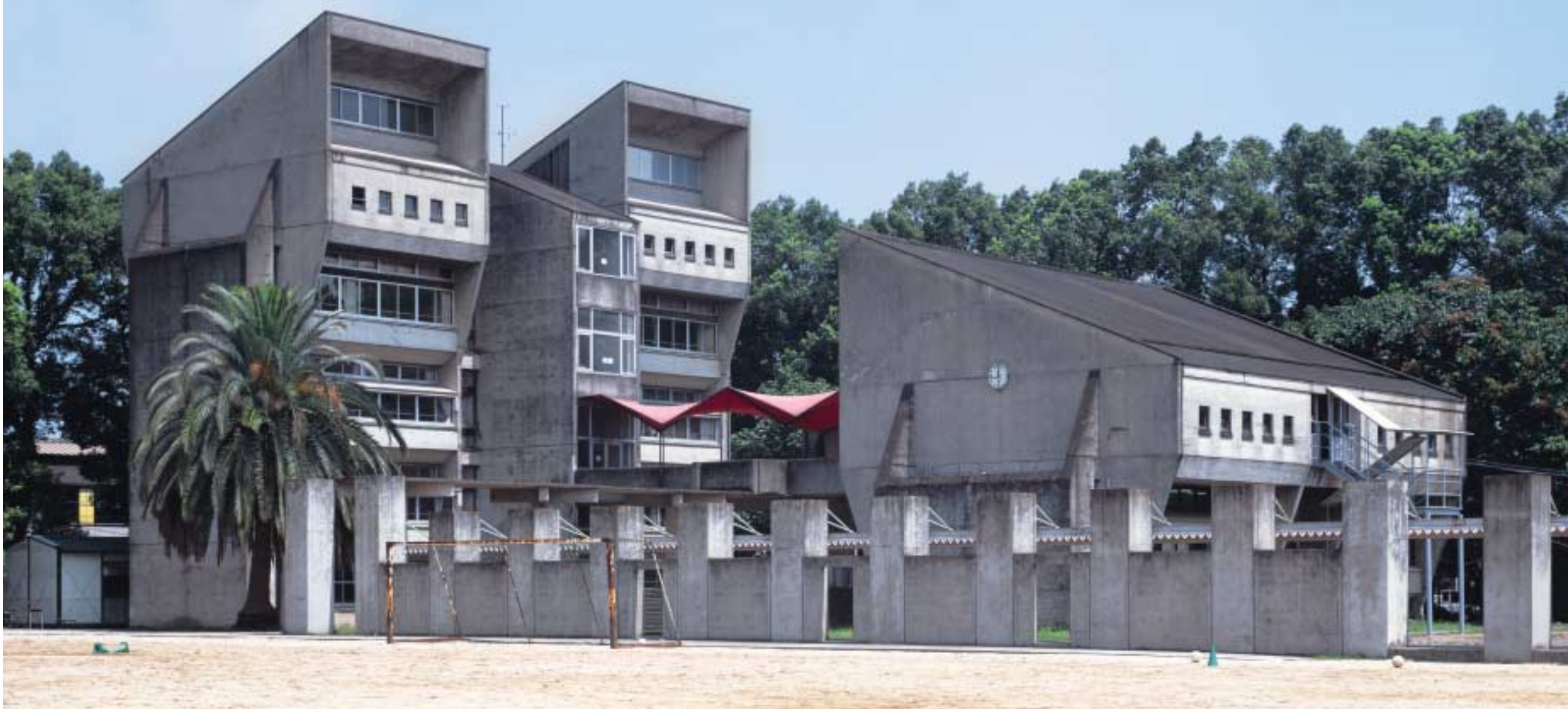
岩田学園 南西面全景
